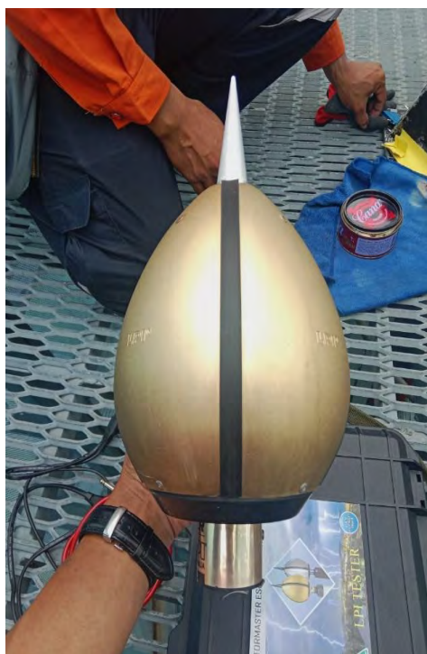
ภาพที่ 7-8 : ภาพแสดงหัวล่อฟ้าหลังทำความสะอาด
