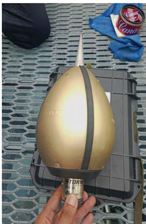
ภาพที่ 3-4 : ภาพแสดงการตรวจสอบและทำความสะอาดหัวล่อฟ้า
