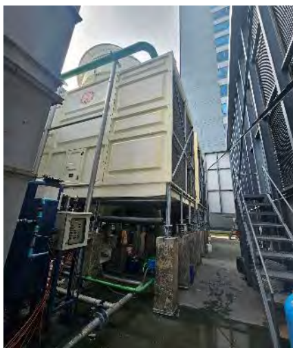
รูปที่ 1.3.10-1 ระบบหอดึงเย็น และช่องระบายอากาศธรรมชาติ
