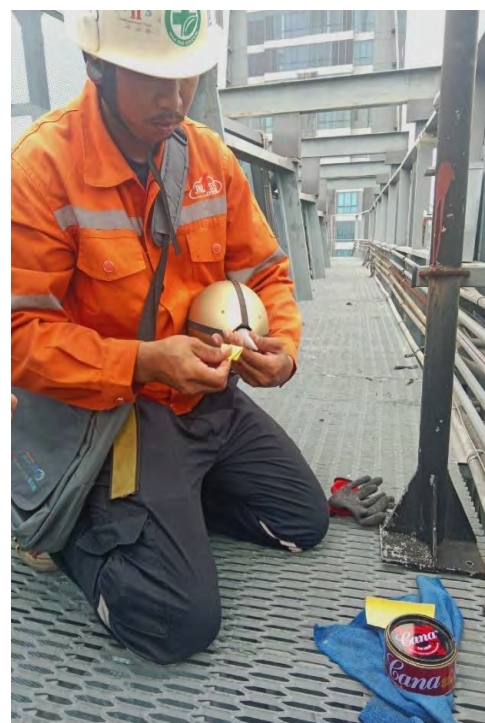
ภาพที่ 3-4 : ภาพแสดงการตรวจสอบและทำความสะอาดหัวล่อฟ้า
