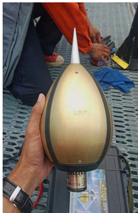
ภาพที่ 7-8 : ภาพแสดงหัวล่อฟ้าหลังทำความสะอาด
